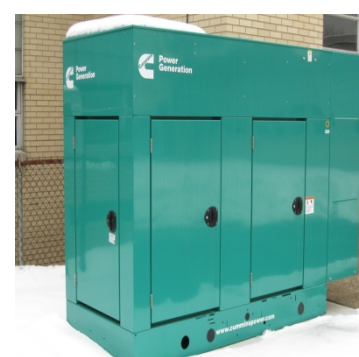
Аварийный эл. генератор
